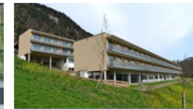
Rehabilitation Center St. Veit im Pongau Austria
